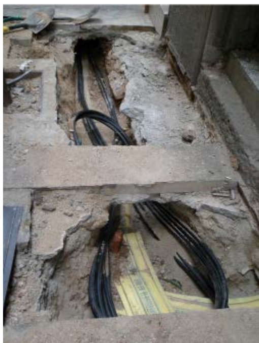
Fig.7.- Rasa 100: Aparició xarxa elèctrica actual i nova escomesa
