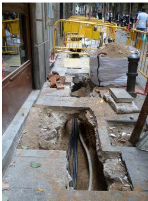
Fig.7.- Rasa 100: Aparició xarxa elèctrica actual i nova escomesa
