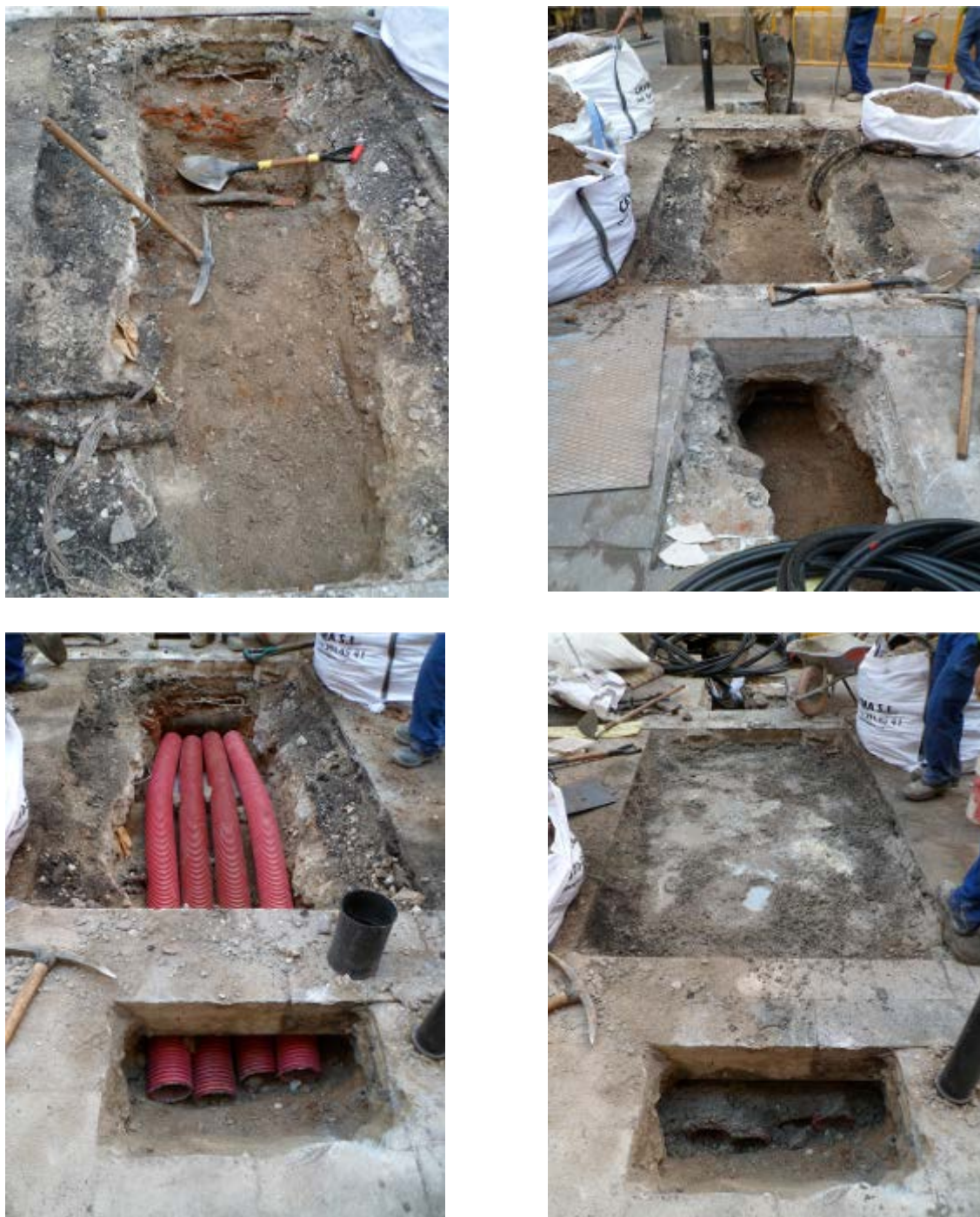
Fig.9.- Rasa 200, excavació i cobertura de la tubular del carrer Avinyó
